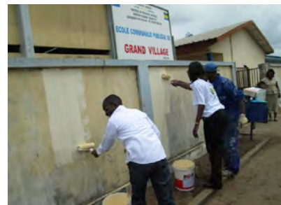
Employés de Ecobank procédant à la rénovation d'un bâtiment de l'Université de Bangui, en République Centrafricaine.
